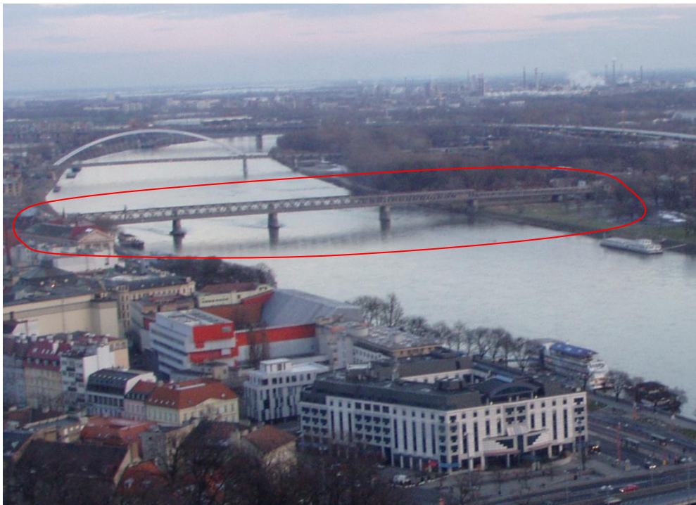
Fig. 8: Bratislava - the „Old Bridge”
